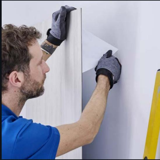
CERABOND+. Rückwand positionieren. Schutzfolie auf der Rückseite lösen.
